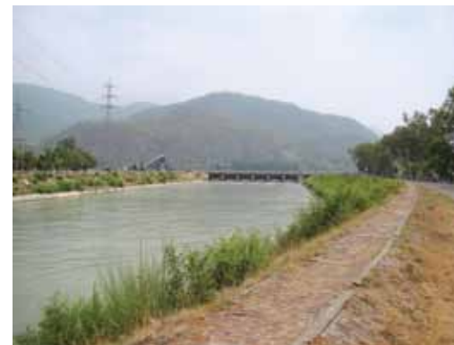
Picture 7: The river Yamuna diverted into a canal in Dakpathar. चित्र 7 : डाकपत्थर पर यमुना का पानी एक नहर में मोड़ दिया गया है।
